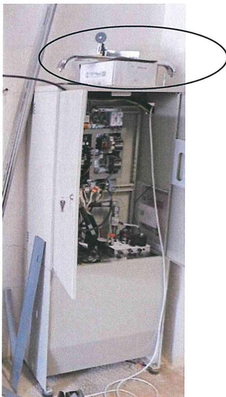
2.- No colocación de sujeción de soporte para la leva eléctrica en cabina. Remitimos fotos del travesaño el cual debe de colocarse para que la leva funcione correctamente. De nuevo, este trabajo deberá realizarlo FUTURELIFT por no haberlo realizado el subcontratista.
