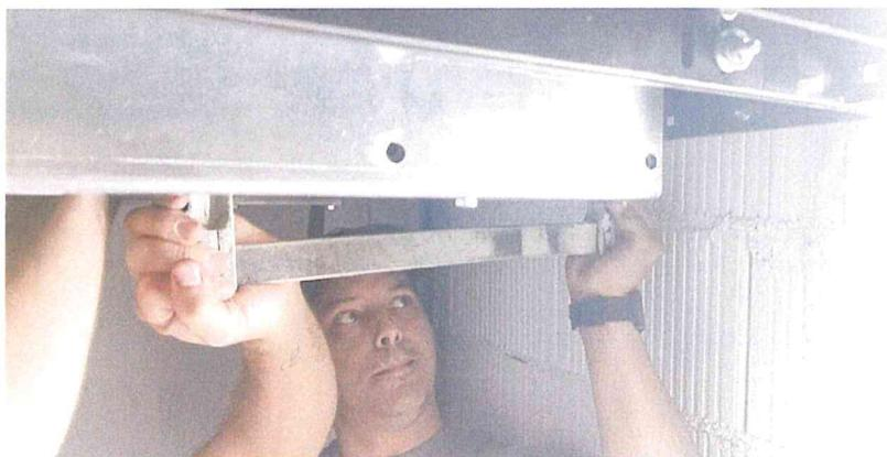
Como se aprecia en la imagen, se ha tenido que desoldar la puerta de rellano de cota 0 para volver a ponerla a peso/alinearla con la plomada respecto a la cabina del elevador y volver a soldar la misma de nuevo para que quede perfectamente alineada.
