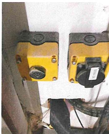
4.- No colocación o falta de instalación final del micro de seguridad de la puerta de rellano de cota 0, así como su mecanismo manual para abrir en situación de emergencia. Finalmente, el pasado 24/07/2025, FUTURELIFT procedió a instalarlo correctamente para que esa puerta se pueda abrir de forma manual y de paso corte el micro de seguridad.
